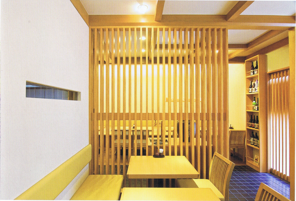
幅2.5cmの棒状の板を5cm間隔に組んで、格子状に仕上げた間仕切り。斜めから見るとその先の視界が遮られ、圧迫感を感じさせることなく目隠しの役目を果たす。
