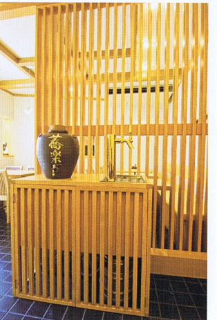
幅2.5cmの棒状の板を5cm間隔に組んで、格子状に仕上げた間仕切り。斜めから見るとその先の視界が遮られ、圧迫感を感じさせることなく目隠しの役目を果たす。
