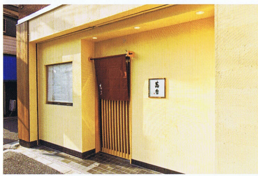
ファサードはクリーム色のジョリパットで暖かい色合いに仕上げ、上部から右にかけてL字にデザインを変えて動きを出す。左端はウリン材を用いてアクセントに。
